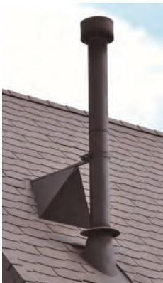
雪の多い地域での施工例です。雪割リとサポートを兼ねた部材で煙突をしっかり支えます。屋根勾配に合わせた調整も可能です。
